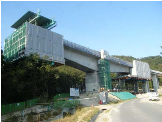
写真-1 施工状況
