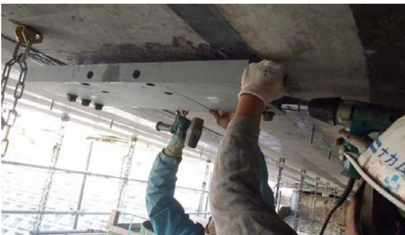
写真-9 固定プレート設置状況
