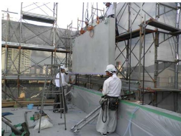
写真-3 壁部材の架設
