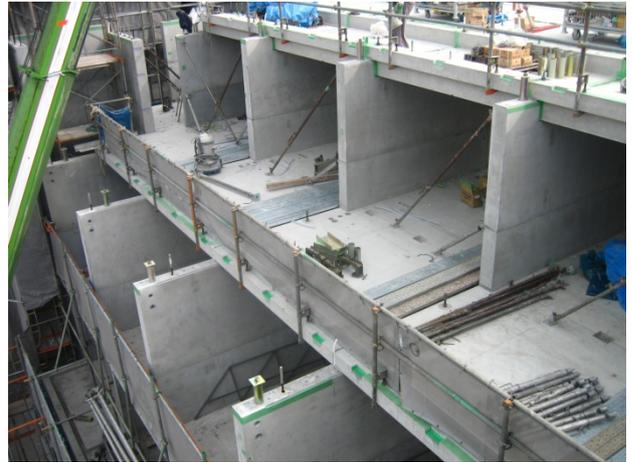
写真-2 ひな壇架設
