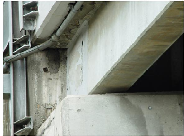
写真-2 横桁横締め定着部のFRP接着工法の変状
