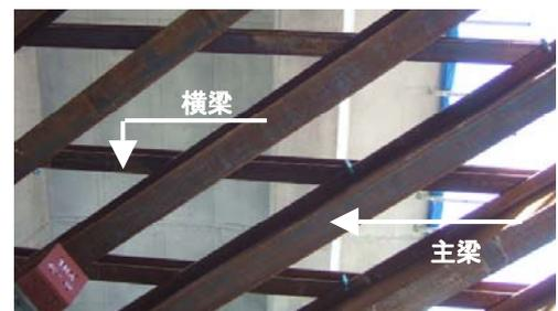
写真-3 梁材施工状況
