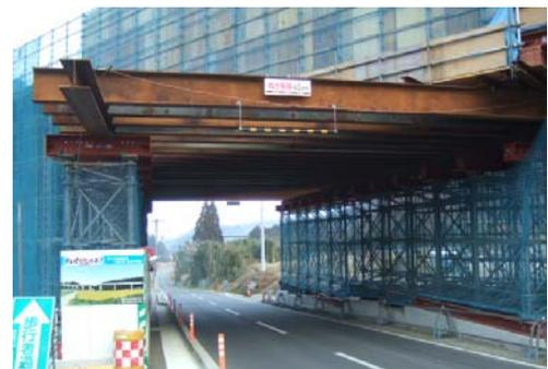
写真-2 支保工施工状況
