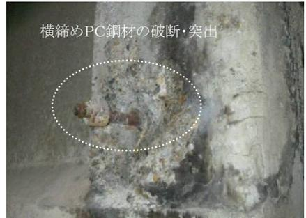
写真-2 横締めPC鋼材の突出
