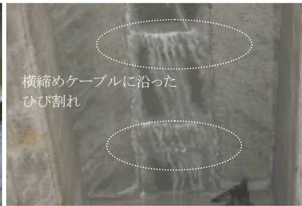
写真-4 間詰め床版下面に発生したひび割れ事例
