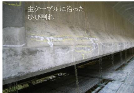
写真-3 PC主桁のグラウト不良によるひび割れ発生事例
