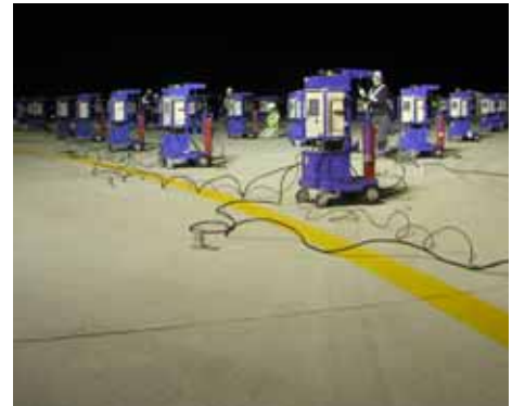
写真-1 施工状況
