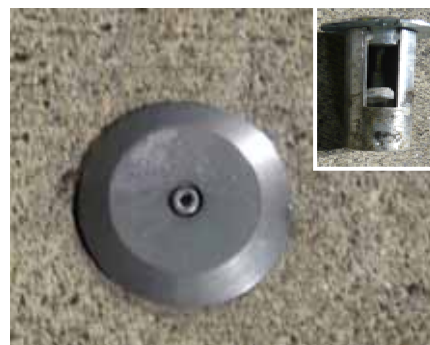
写真-5 注入孔蓋設置状況
