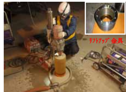
写真-3 コア削孔状況
