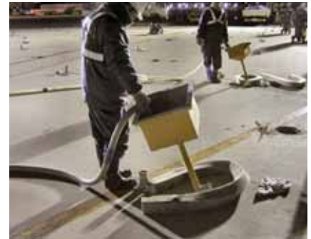
写真-9 グラウト注入状況
