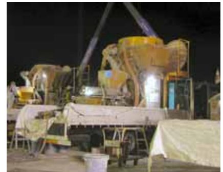
写真-8 グラウト練り混ぜ状況
