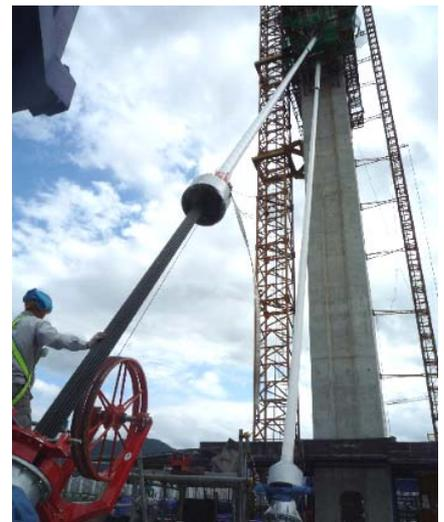
写真-2 ストランド架設状況写真
