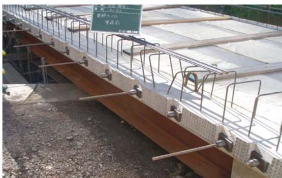
写真-9 横締めケーブル配置状況
