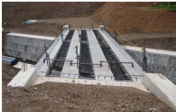
写真-6 主桁架設完了
