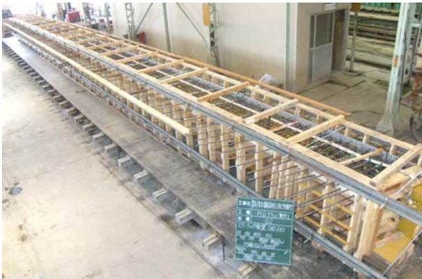
写真-3 型枠・鉄筋組立完了
