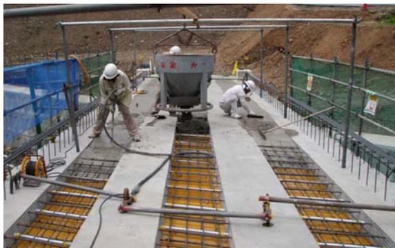
写真-7 コンクリート打設状況
