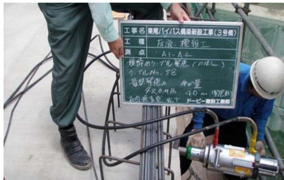
写真-8 横締めケーブル緊張状況
