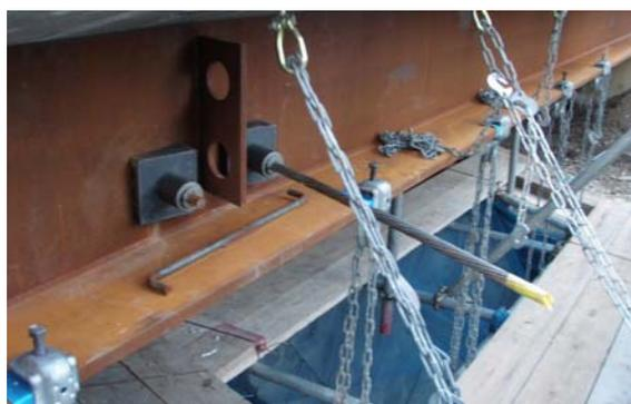
写真-10 横締めケーブル配置状況(中間横桁)
