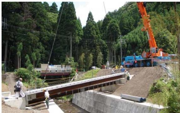
写真-5 主桁架設状況
