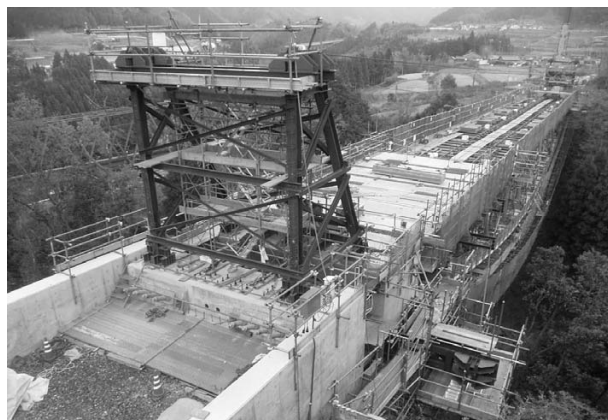
写真-3 上床版セグメントの架設
