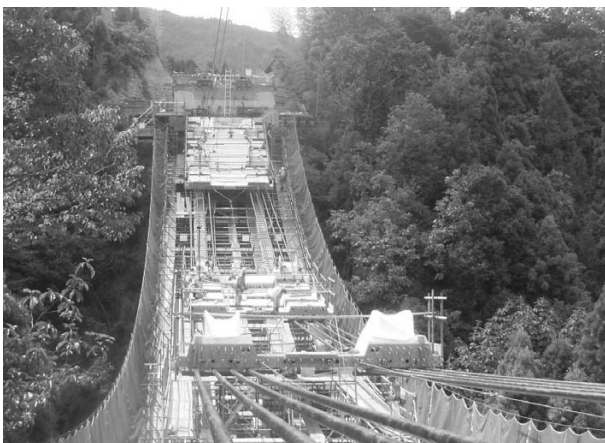
写真-1 吊床版セグメントの架設
