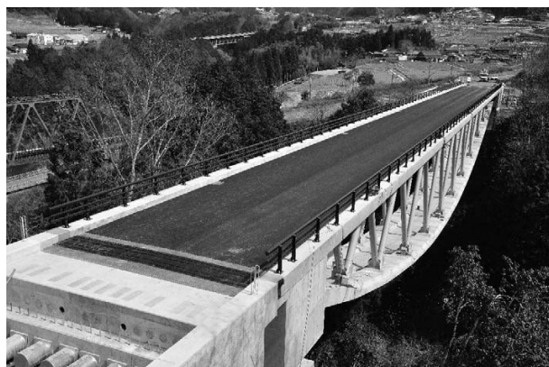
写真-5 完成写真
