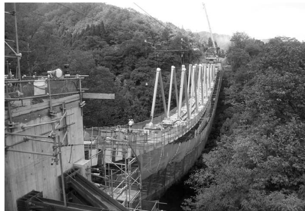
写真-2 鋼斜材の架設
