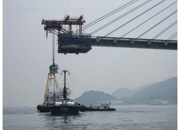
写真-5 接合桁架設状況
