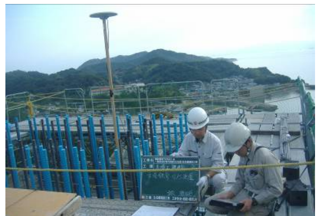
写真-2 主塔鉄骨のGPS測量
