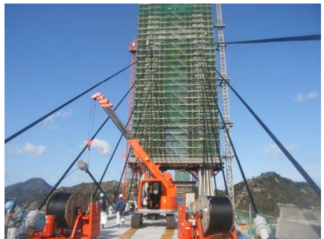
写真-4 斜材の施工状況
