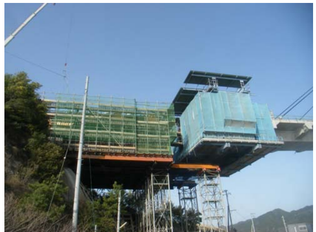
写真-3 側径間の施工状況
