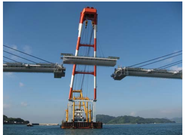
写真-6 鋼桁閉合状況
