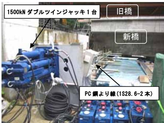
写真-3 A1 橋台移動設備
