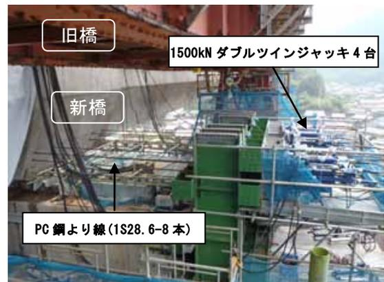
写真-4 P1 橋脚移動設備
