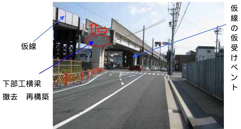
写真-1 施工前全景
