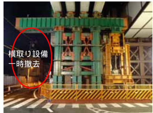
写真-2 P96 横取り設備 交通解放時
