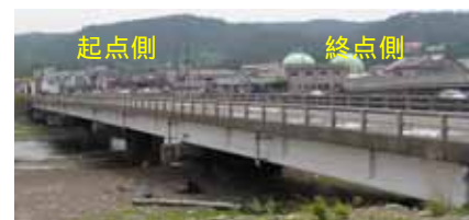
写真-1 対象PC橋の全景
