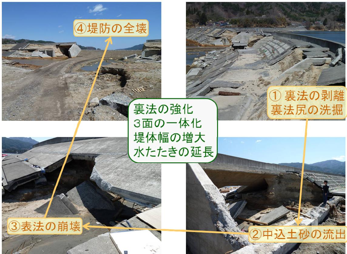
図-5 海岸堤防の被災
