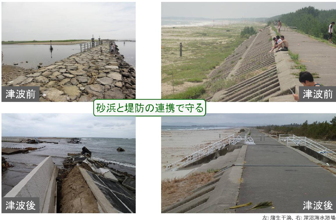
図-6 海岸堤防前面の砂浜の防護
