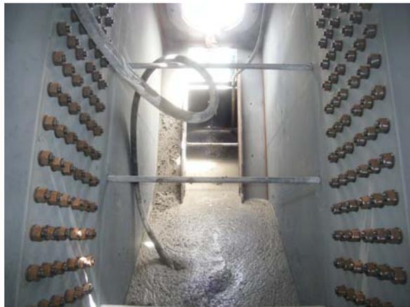
写真-2 鋼管充填状況
