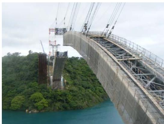
写真-1 鋼管架設状況
