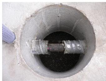
図-2 PC 鋼棒切断用の円形孔
