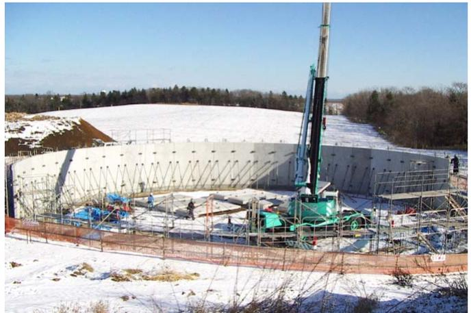
写真-1 側壁部材建て込み状況
