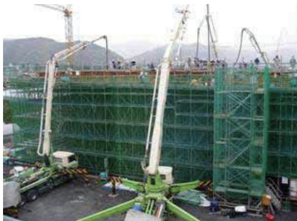
**写真-1 打設状況 (終点側より望む)**
