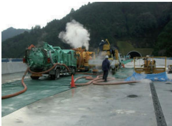
写真-2 床版打継ぎ部のコンクリートはつり状況
