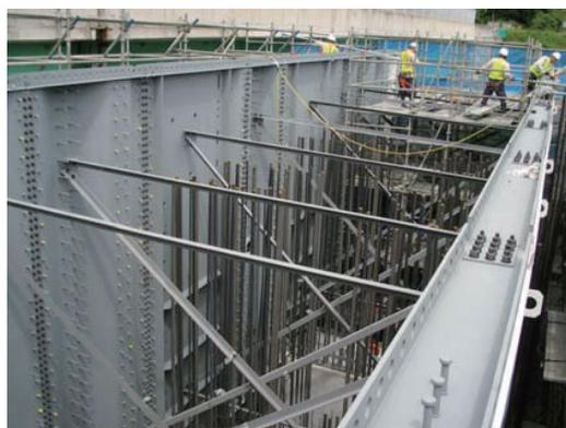
写真-1 柱頭部の波形架設
