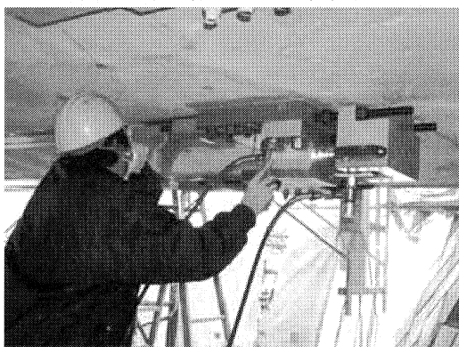
写真-4 緊張作業
