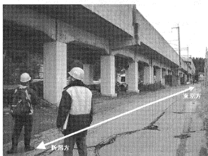
写真-13 補強した無被害の橋脚
