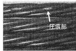
写真-5 被膜損傷状況
