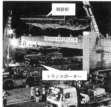
写真-1 架設桁設置状況
