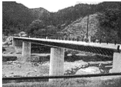
写真-1 橋梁全景
