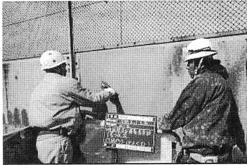
写真-2 下塗り施工状況
