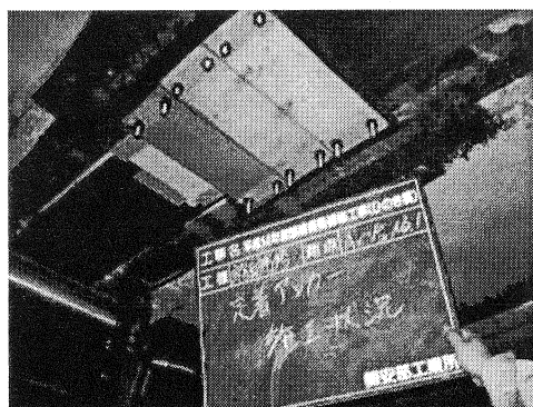
写真-7 定着プレート取付状況
