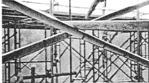
写-3 ブレース材の配置
