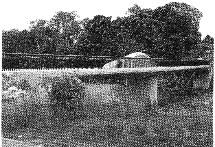
写真 1 鳥崎川橋全景
