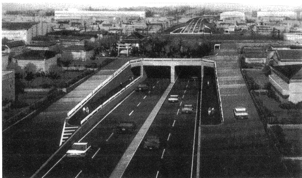
写真-6 完成写真
