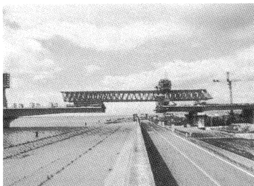
写真—3 側径間架設状況
