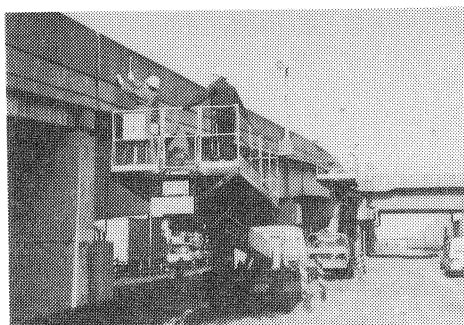
写真－1 橋梁遠景
