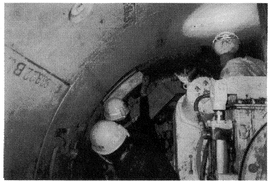
写真-5 K型セグメント組立状況
