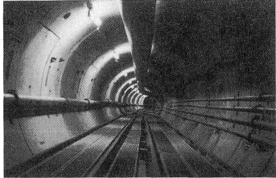
写真-2 坑内状況
