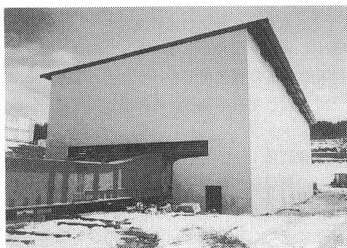
写真-1 上屋設備
