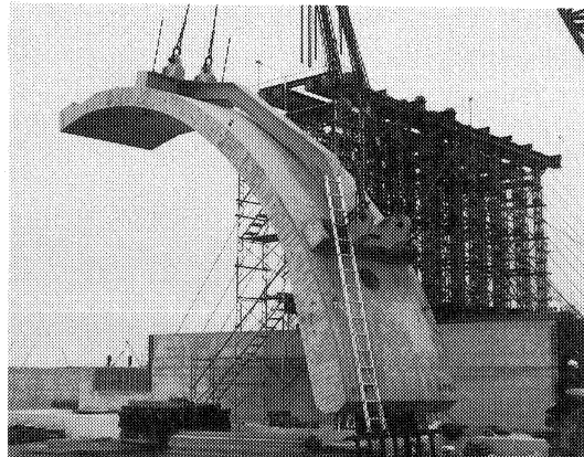
写真-4 プレキャスト部材の据付
