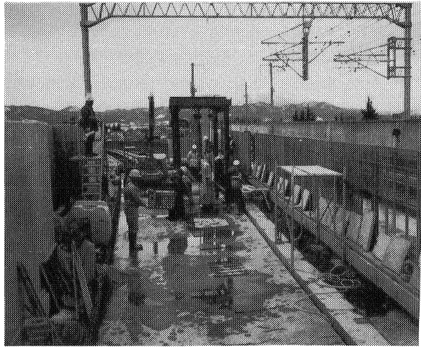
写真-3 既設高欄撤去状況
