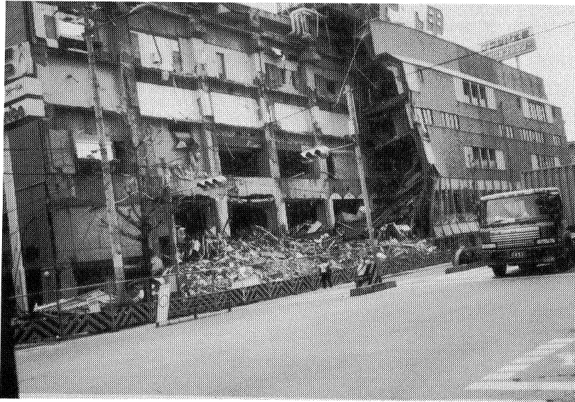
写真-8 グランド六甲ボウル 場所打ちPC造一部S造（S造側から撮影）
