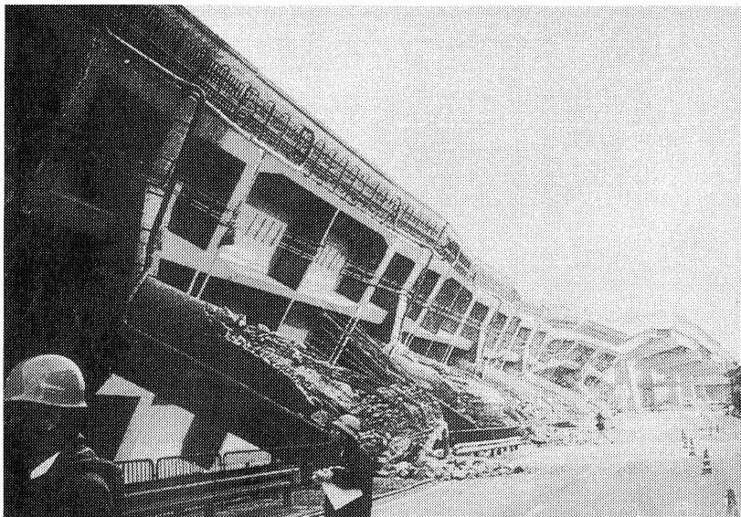
写真-1 阪神高速道路 高速神戸線 ビルツ橋
