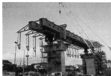
写真-4 移動支保工組立
