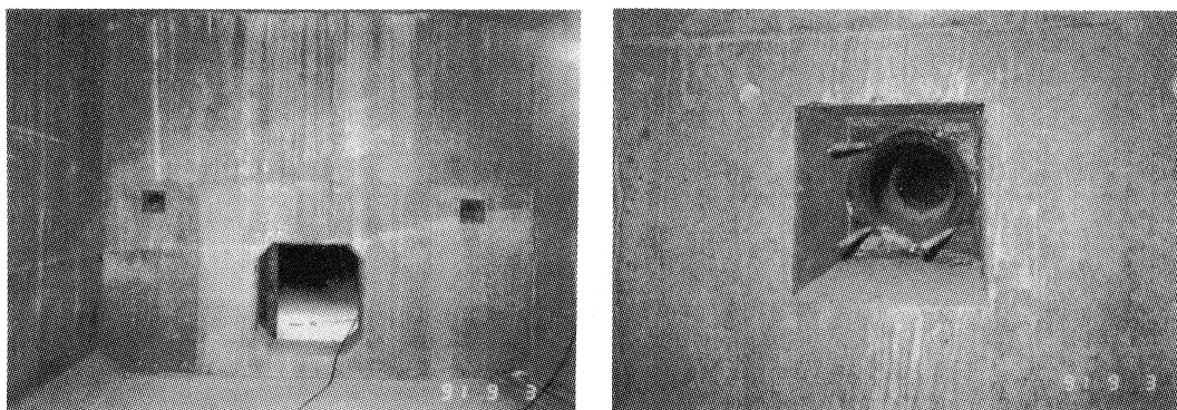
写真-3 横桁部定着具配置状況
