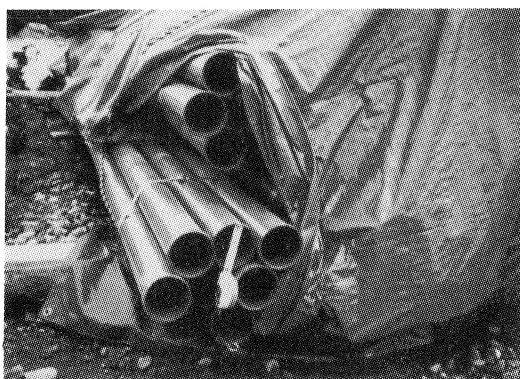
写真-4 外ケーブル保護管
