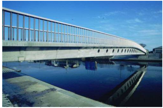
写真-12 UFC橋梁 (酒田みらい橋)
