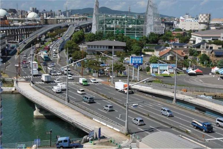
型 式：2 径間連続 P C 箱桁橋
