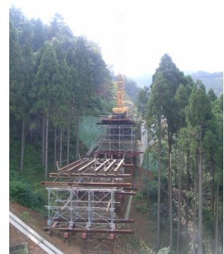
写真-3 支保工施工状況
