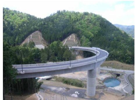
写真-1 完成写真
