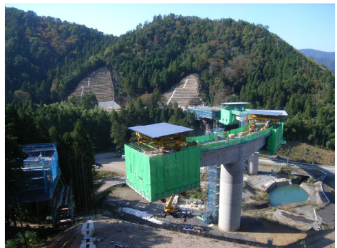
写真-2 張出し施工状況
