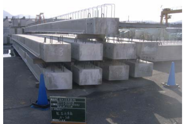
写真-2 主桁完成写真
