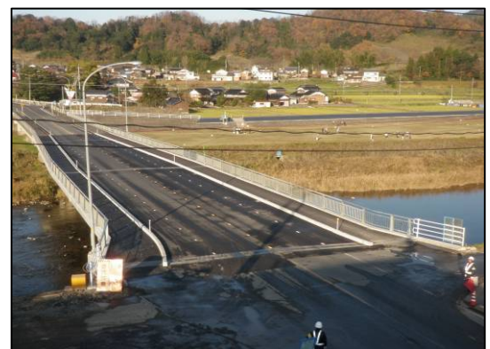
写真-2 完成写真
